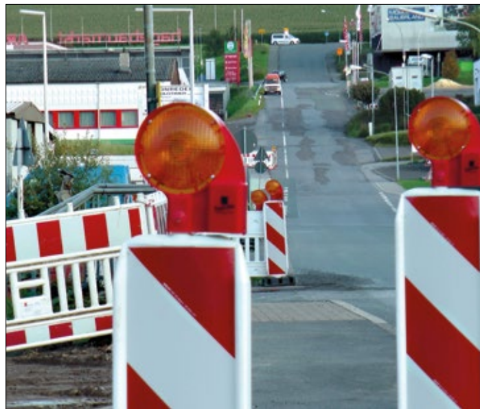
Die Bauarbeiten am Hüttenweg haben begonnen. Noch ist nicht viel zu sehen, doch bald gibt es eine Vollsperrung. Foto: Krahl
